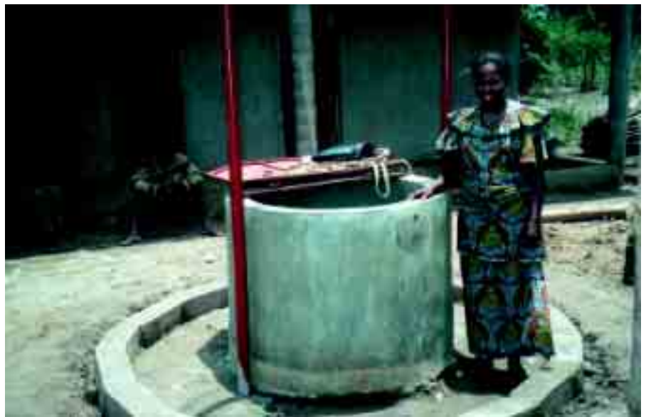
Schachtbrunnen sind wesentlich billiger als das Bohren eines Brunnens.
