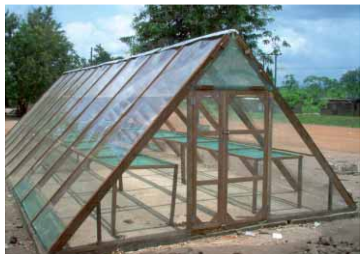
Der Solartrockner in der Hodzo-Region wurde in Gemeinschaftsarbeit nach kurzer Bauzeit fertig gestellt.
